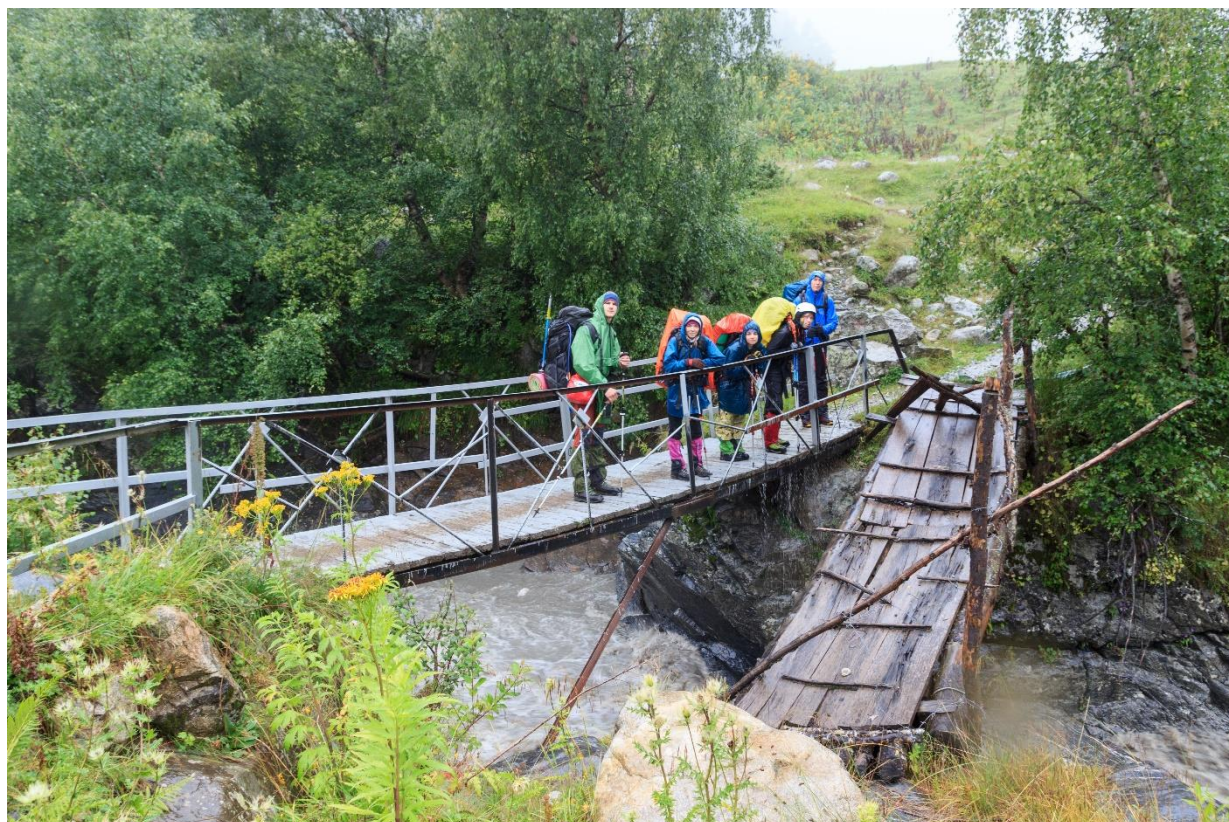
Фото 4.5.4. Мост через р. Карасу около погранзаставы
